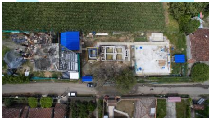
Obra - PTAP Nariño – Vista en planta
