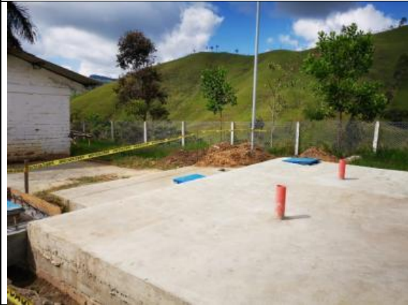
Avance tanque de almacenamiento
